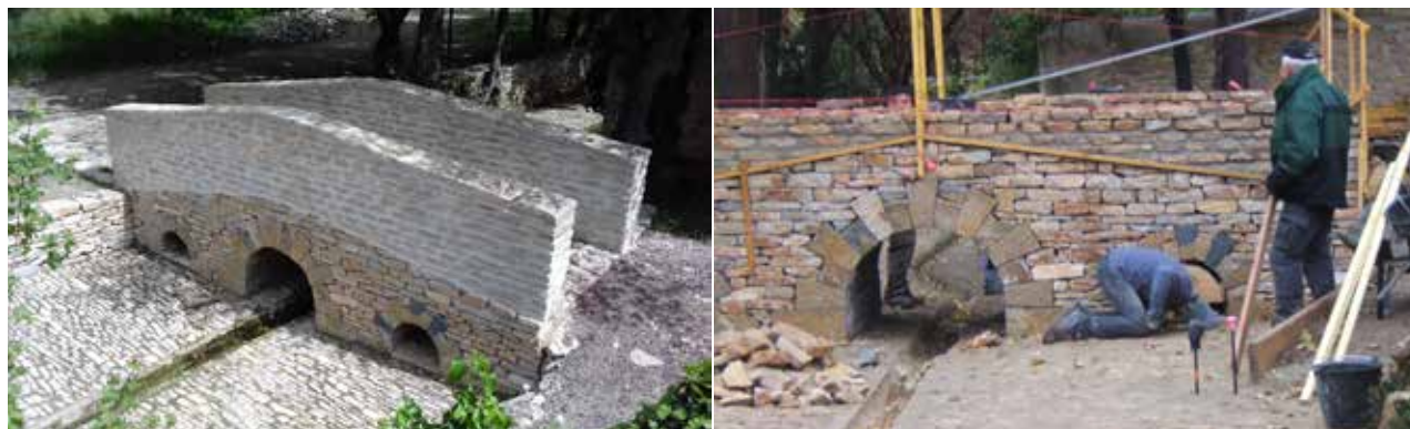
Chantier d'insertion dans les Gorges du Gardon
