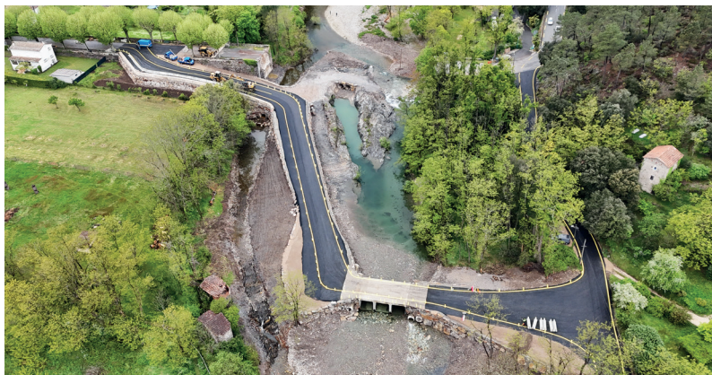
Le pont provisoire des Châtaigniers, reliant Chamborigaud à Génolhac a été construit en un mois seulement
