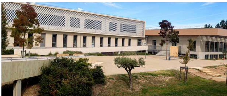
La transition énergétique est intégrée lors des travaux de rénovation des collèges, comme au collège Voltaire à Remoulins, qui a d'ailleurs obtenu le Grand Prix des Trophées Bâtiments Résilients 2024.
