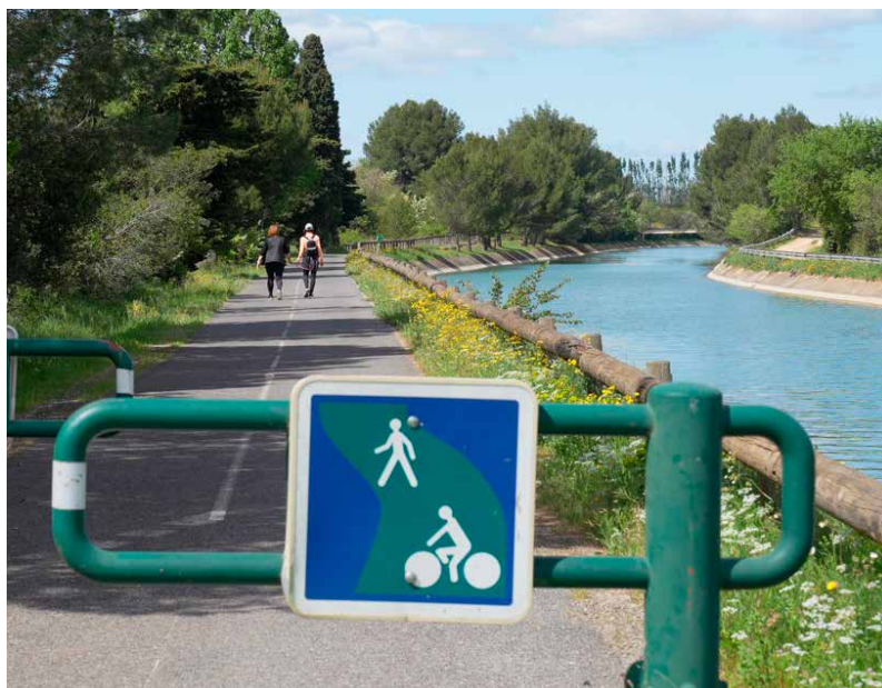
Les travaux de la voie verte de Gallician ont été achevés en 2025.
